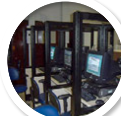
Figura 9: Central telefônica – 2008 (operação). Fonte: Arquivo do Disque Denúncia .
